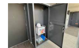
専用防災備蓄倉庫
